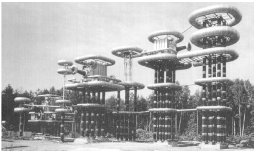
Figura 36 - Impianto HVAC da 3000 kV.
